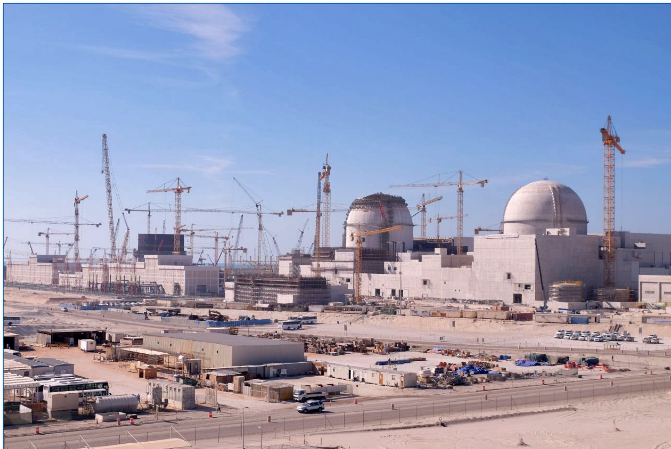
Výstavba jaderné elektrárny Barakah ve Spojených Arabských Emirátech
