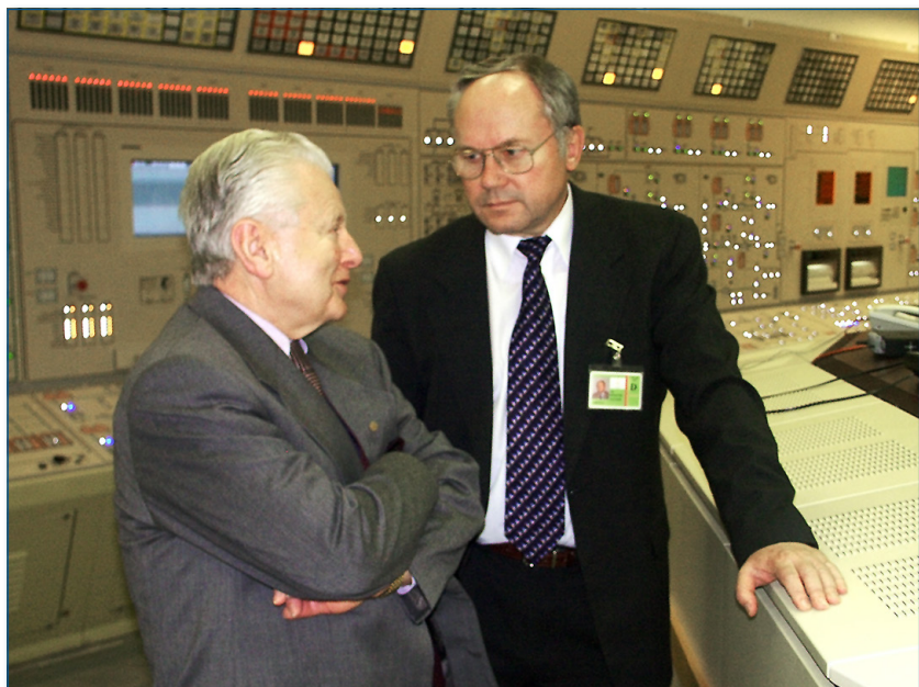
Spouštění druhého bloku jaderné elektrárny Temelín, červen 2002: Ministr průmyslu Miroslav Grégr a ředitel elektrárny František Hezoucký.
